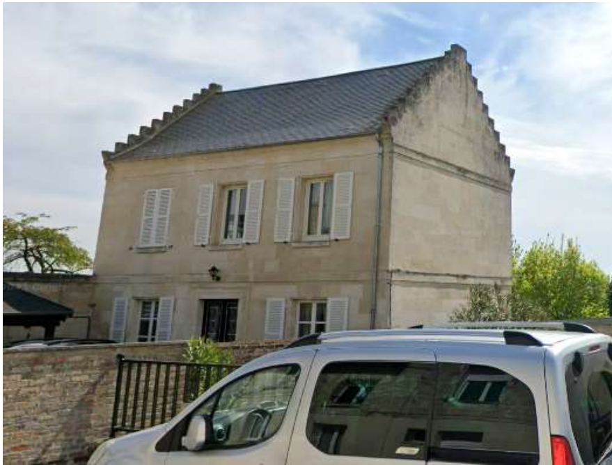
Une architecture typique du Soissonnais à Bucy-le-Long
